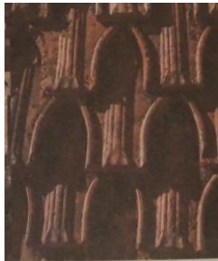
Des tuiles dites « violon », en raison de la ressemblance avec l'instrument de musique recouvraient les anciennes constructions.
