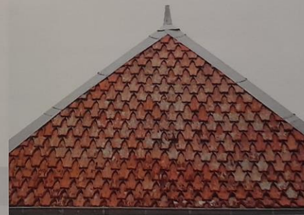
Toiture composée de tuiles violon.
